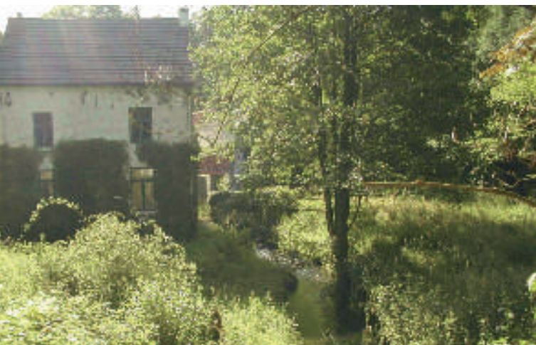
Moulin sur le Ry du Pré Delcourt
