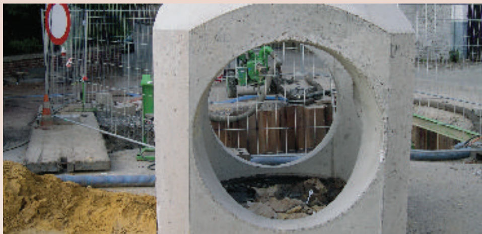
Pose du collecteur du Train à Grez-Doiceau
