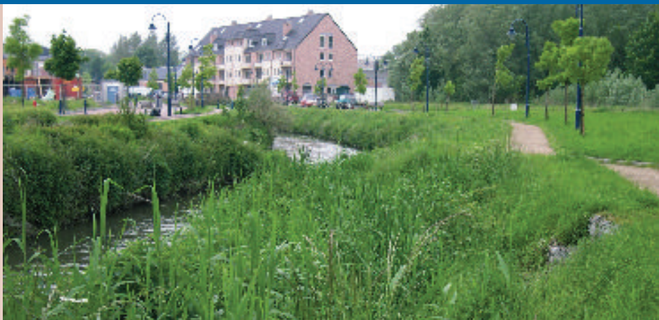
Remise à ciel ouvert de la Thyle dans le centre de Court-Saint-Étienne
