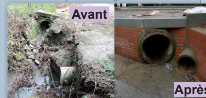
Réfection d'ouvrages d'art
